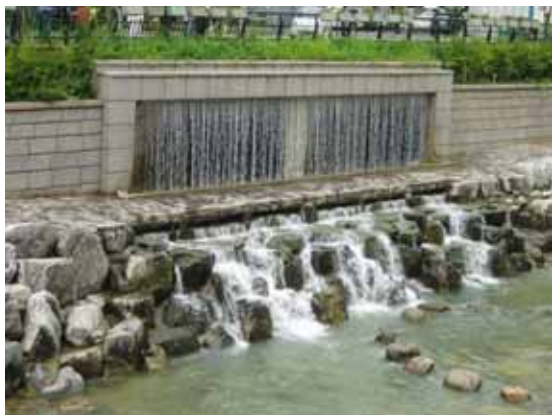
< 大規模排水路幹線の合流点 > (2006.7.28 撮影)
