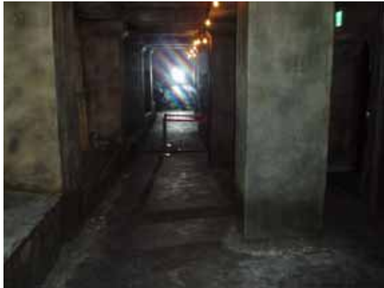
< 清溪川復元前の暗渠内地下空間 > ( 2006.7.27 撮影 )
