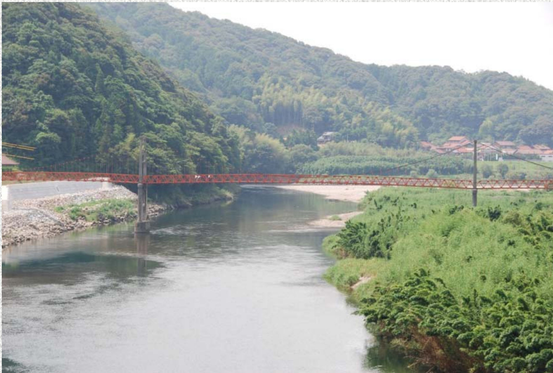
下流側からスタート地点の安富つり橋を望む。
