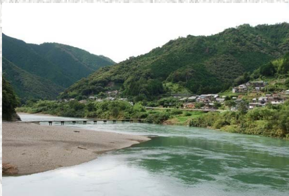
岩間沈下橋（2011.8.7撮影）
